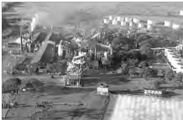
Instalaciones de Abengoa en Brasil.
