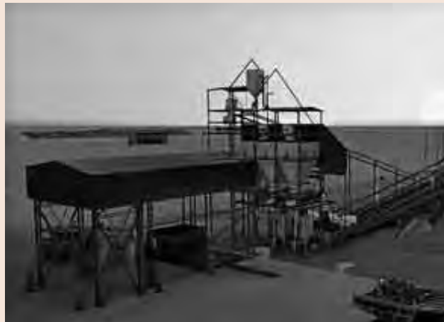
Imagen de las instalaciones en Zouérat (Mauritania).
