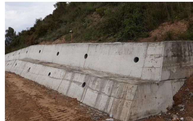
*Hormigonado de la estructura de anclajes.*
